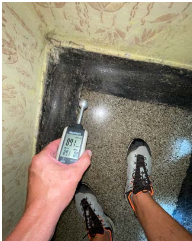
Spodní úroveň - Vlhkost 20%
