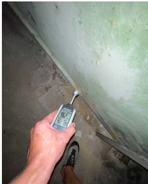
Spodní úroveň - Vlhkost 22%
