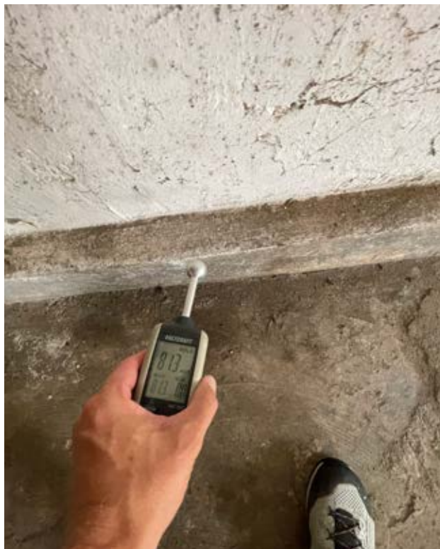
Spodní úroveň - Vlhkost 16%
