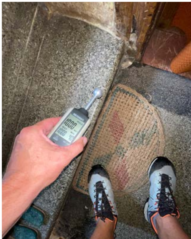
Spodní úroveň - Vlhkost >24%
