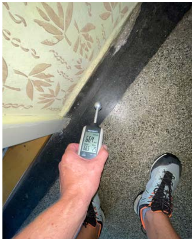
Spodní úroveň - Vlhkost 11%
