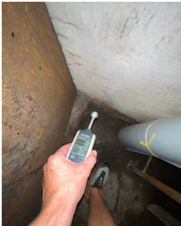
Spodní úroveň - Vlhkost >24%
