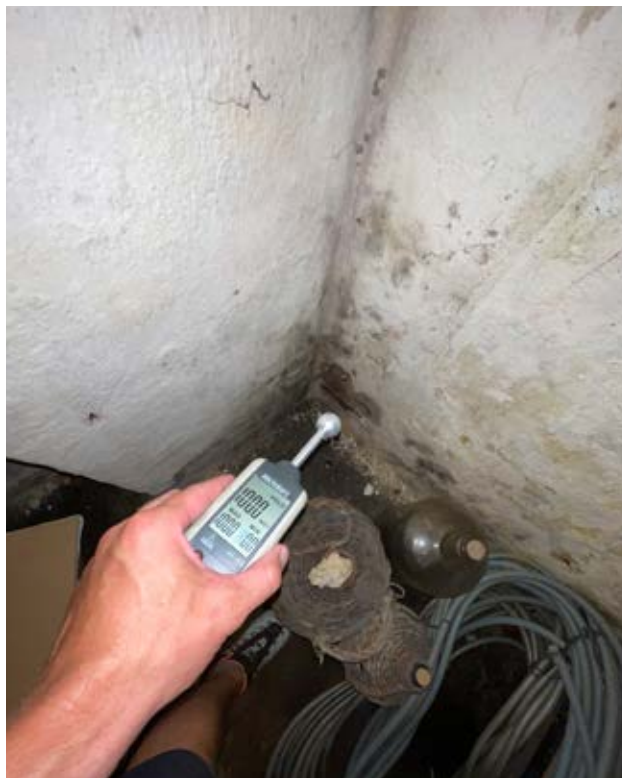
Spodní úroveň - Vlhkost >24%
